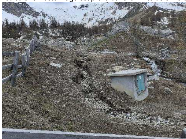
fossé à conforter.
