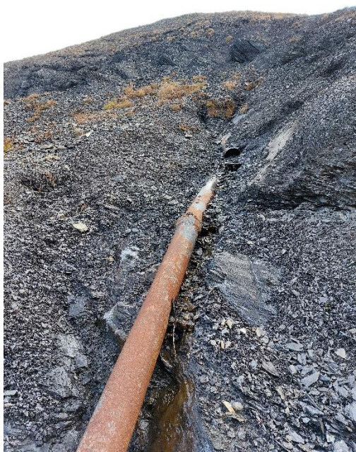
La canalisation actuelle en sortie du tunnel.
