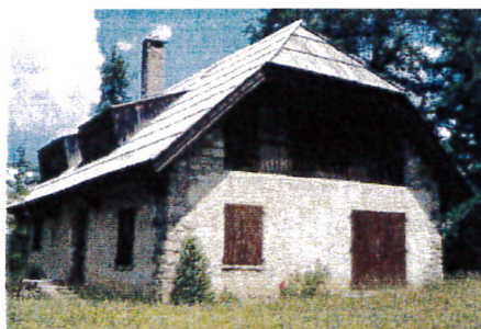
Couvertures en bardeaux de mélèze récentes au Villard bac acier "gris lauze"
