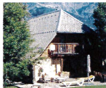
Couvertures en bardeaux de mélèze récentes au Villard bac acier "gris lauze"
