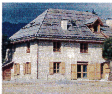
Couvertures en bardeaux de mélèze récentes au Villard bac acier "gris lauze"
