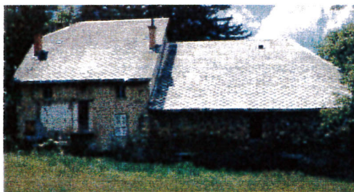
Couvertures en ardoises artificielles au Villard et au village
